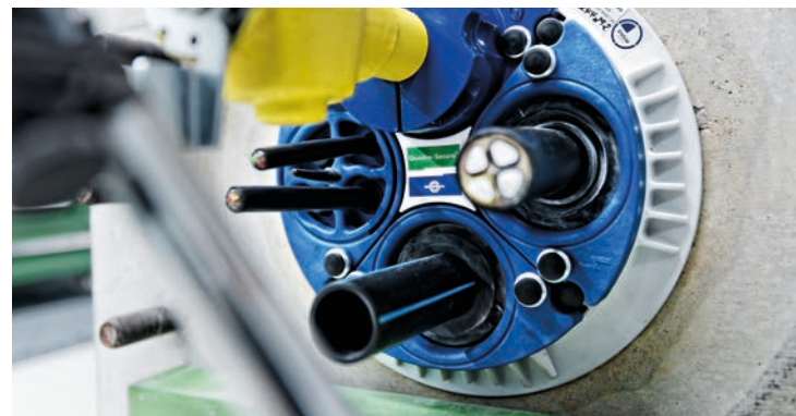
Belastungsgrenzen-Test an Mehrsparten-Hauseinführung
