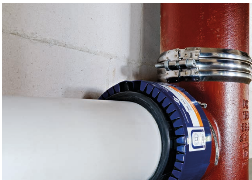
Curaflam® Konfix Pro nach dem Einbau auf der Baustelle
